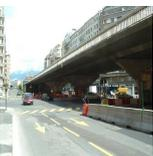
Les inclinomètres seront positionnés sur les piliers et les tabliers. L'inclinaison du pilier sera mesurée par les inclinomètres fixé sur celui-ci. L'affaissement du pilier sera mesuré grâce aux informations provenant des inclinomètres placés sur les tabliers.
