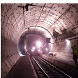
Le capteur ODS positionné sur la partie supérieure du tunnel permettra d'en mesurer un éventuel affaissement, la déformation de la voûte suivant l'axe du tunnel est également contrôlée par l'inclinomètre présent dans l'ODS. En utilisant un ODS positionné sur les côtés, la convergence du tunnel est également mesurable.
