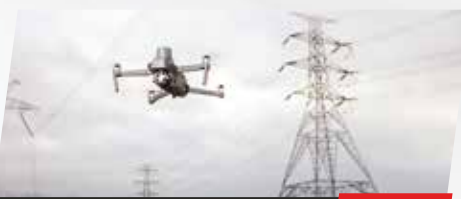
Inspection de pylons, éoliennes, ouvrages d'arts
